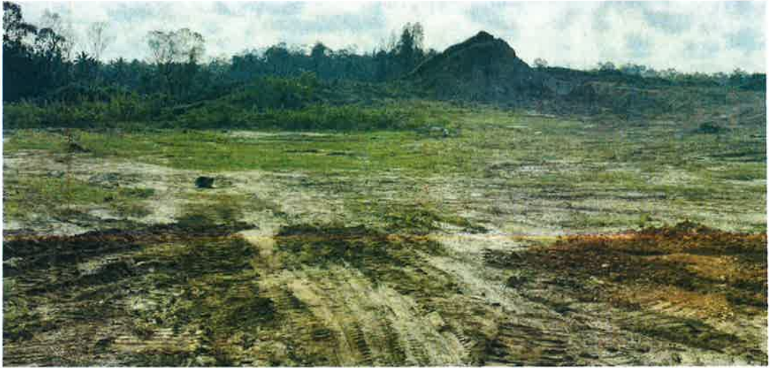
生产路1 施工前
