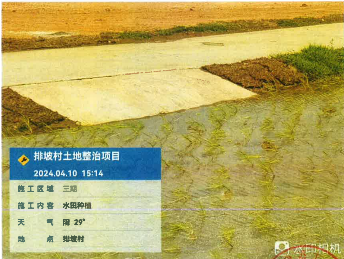
下田坡道施工后
