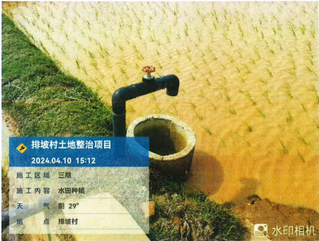
灌溉管道施工后
