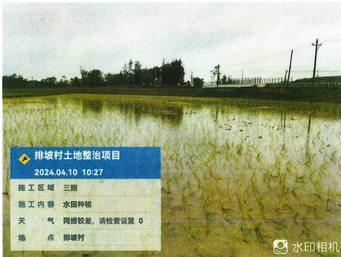
3号地块施工后
