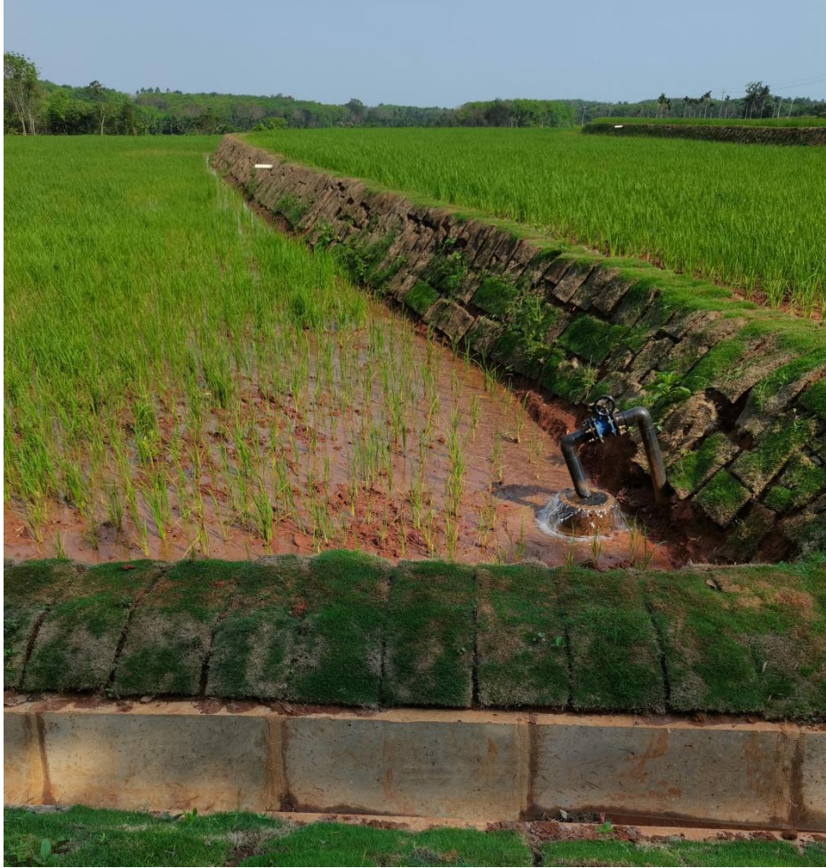
图6 海口市琼山区三门坡镇铁炉土地整治项目实地照片5
