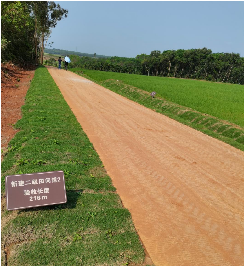
图5 海口市琼山区三门坡镇铁炉土地整治项目实地照片4
