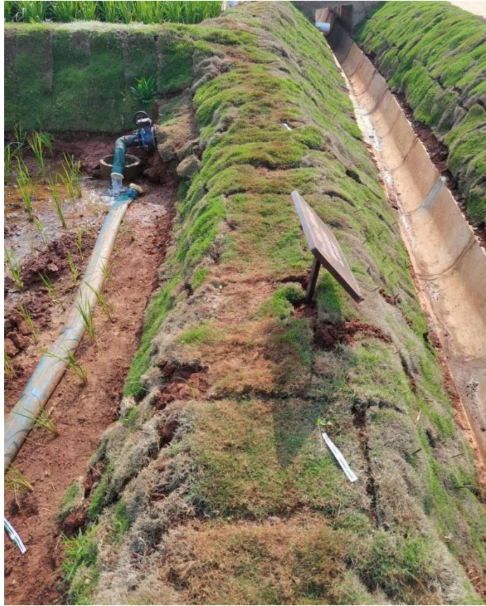
图8 海口市琼山区三门坡镇铁炉土地整治项目田埂示例照片
