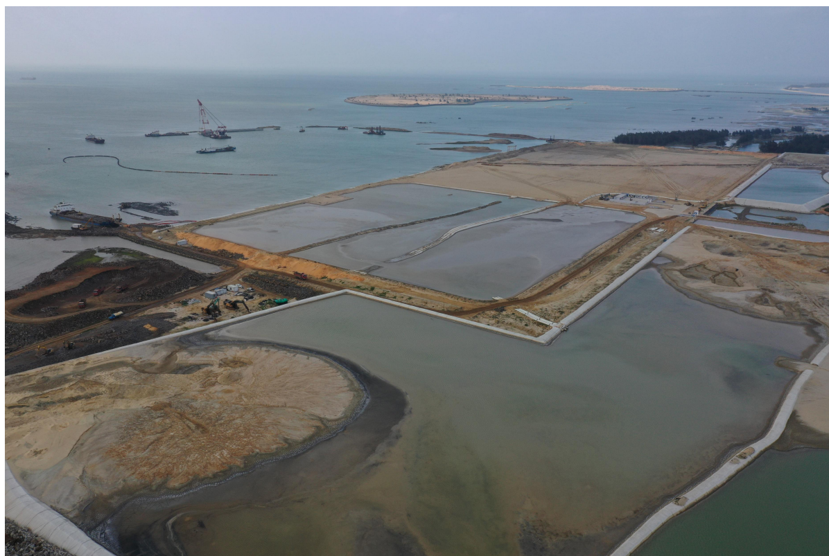
照片 2.1-2d 铺前中心渔港施工区现状照片
